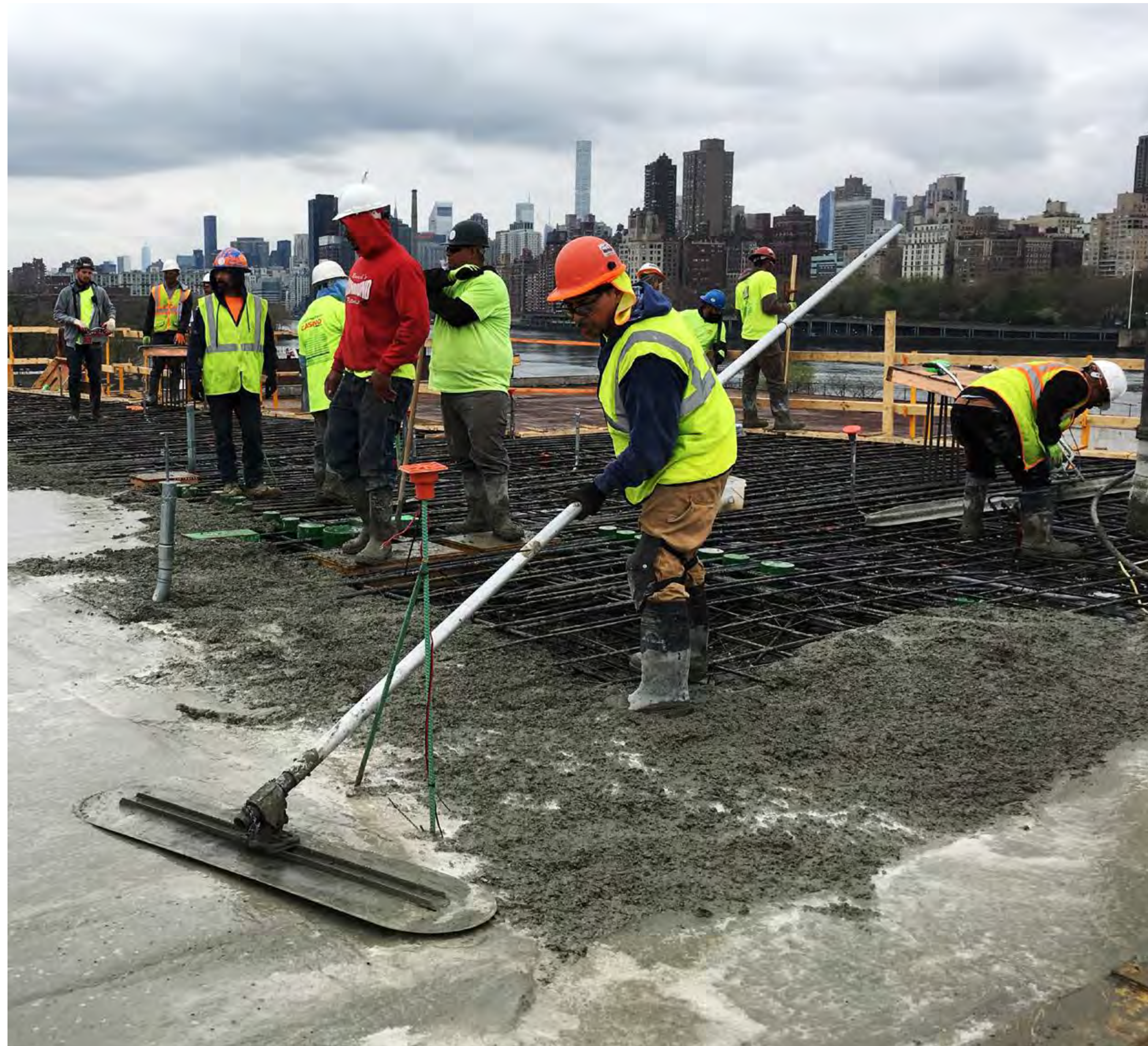
Pilot pour using concrete containing glass pozzolan, Halletts Point
